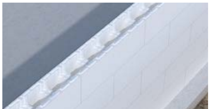
16 Mur de la piscine monté. Il est impératif de croiser les pièces entre les rangs inférieurs et supérieurs au minimum de 25 cm
