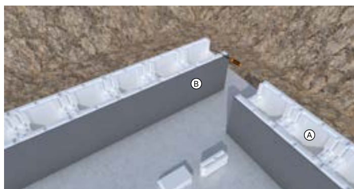
4 Découpe du passage béton du bloc B
