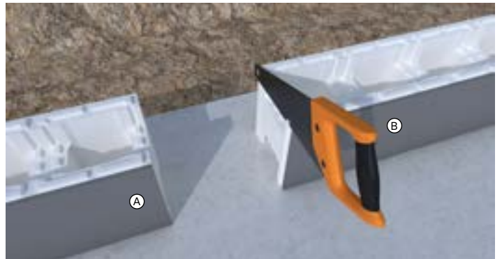
12 Pour assembler un bloc recoupé A, vous devez couper le tenon du bloc à assembler B
