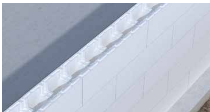
16 Zwembadmuur gemonteerd. Het is nodig om de verschillende blokken van de bovenste en onderste rijen minimaal 25 cm te laten overlappen
