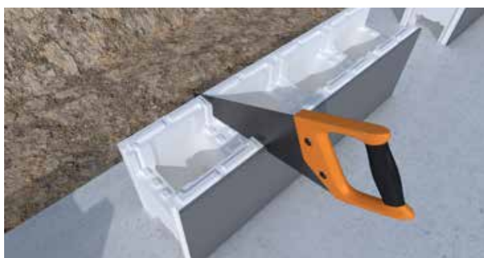
11 Als u een snijbewerking moet uitvoeren op een blok, snij dan steeds in het midden van een verbindingsstuk en volg hierbij de markeringen
