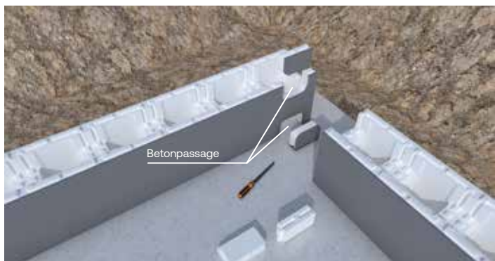
5 Betonpassage boven- en onderaan
