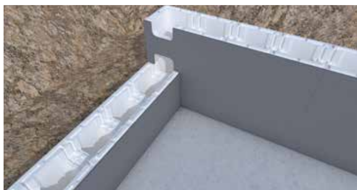
14 Montage van de hoekblokken van rij 2
