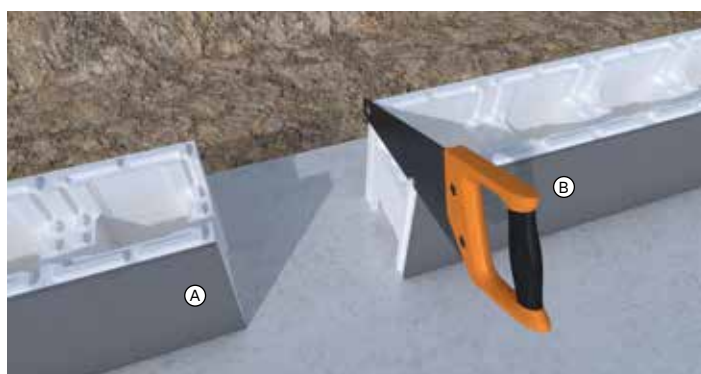
12 Om een ingekort blok A te monteren moet u de tand van het in elkaar te zetten blok B doorzagen.
