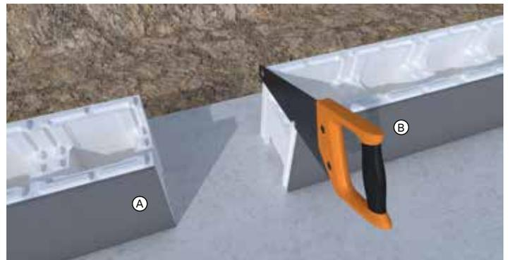
**12** Um einen zugeschnittenen Block A zu montieren, müssen Sie den Zapfen am zu montierenden Blocks B abschneiden.
