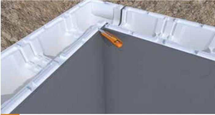
**17** Nach Abschluss der Montage der Reihen schneiden Sie die äußeren und inneren Zapfen der letzten Reihe ab.
