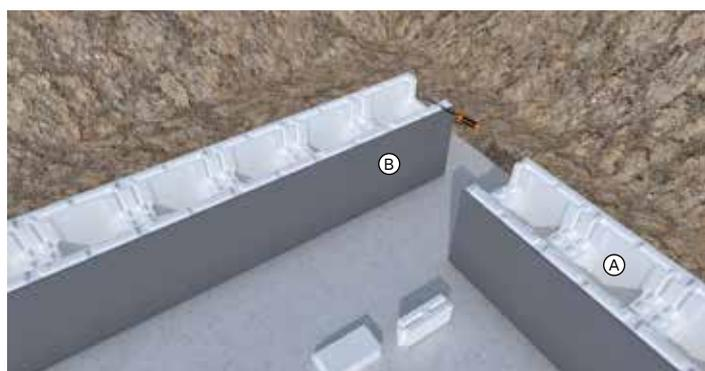
4 Zuschnitt der Betonaussparung von Element B
