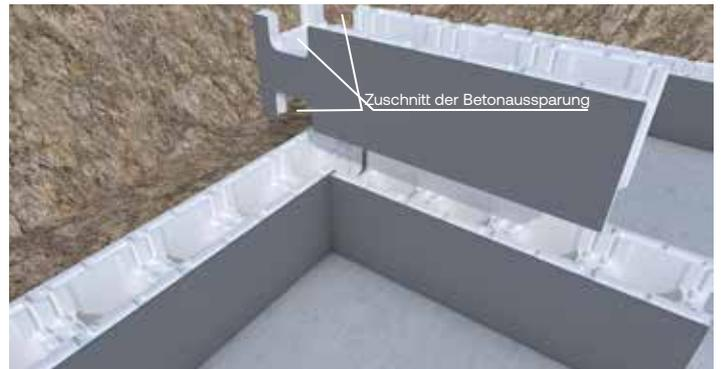
**2** Montage des Trennwandelements der zweiten Reihe mit ausgeschnittener Betonaussparung
