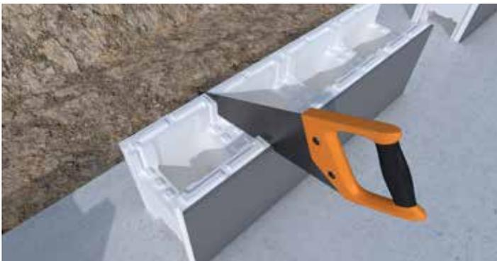
**11** Wenn ein Element zugeschnitten werden muss, schneiden Sie immer an den Markierungen in der Mitte eines Zwischenstücks.
