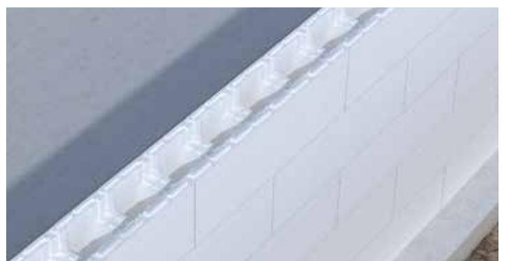
**16** Montierte Wand des Pools. Sie müssen die Teile zwischen den unteren und oberen Reihen unbedingt mindestens 25 cm versetzt anordnen.
